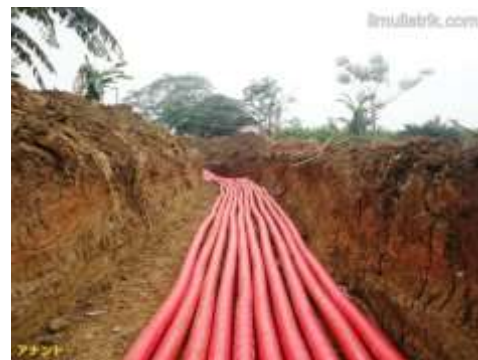
Gambar 2-2. Saluran Kabel Tegangan Menengah (SKTM) (Bejo, 2013)
