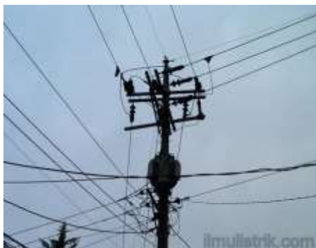
Gambar 2-1. Saluran Udara Tegangan Menengah (SUTM) (Bejo, 2013)
